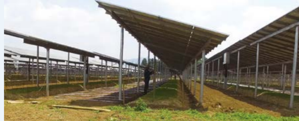
日本茨城筑波光伏电站
