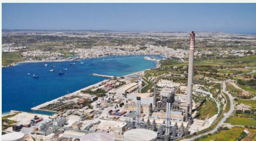
马耳他 D3 发电厂全景
