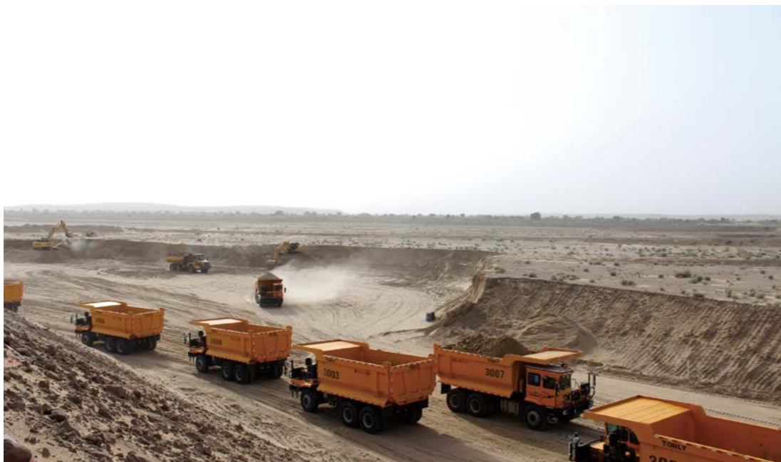
巴基斯坦塔尔煤田二区块露天矿现场
