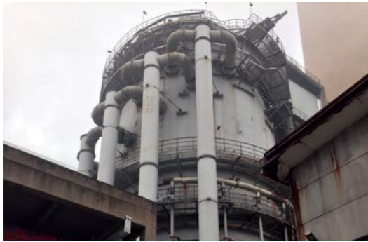
改造机组脱硫吸收塔
