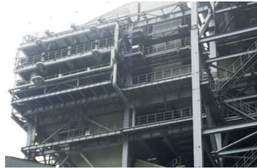
改造机组脱硝装置
