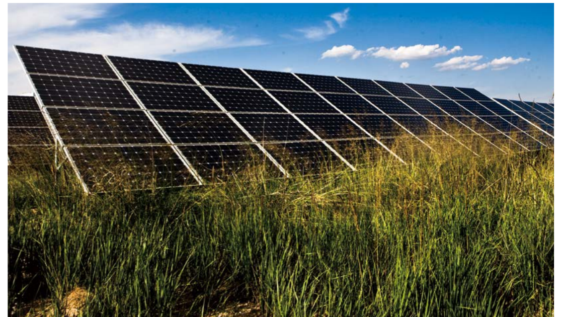
植被得到有效修复，子阵区内风速及晴天天气蒸发量平均降低 50% 以上，土地的含水量大大增加
