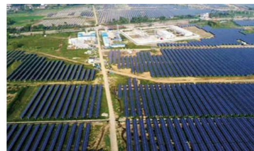
光伏电站航拍图
